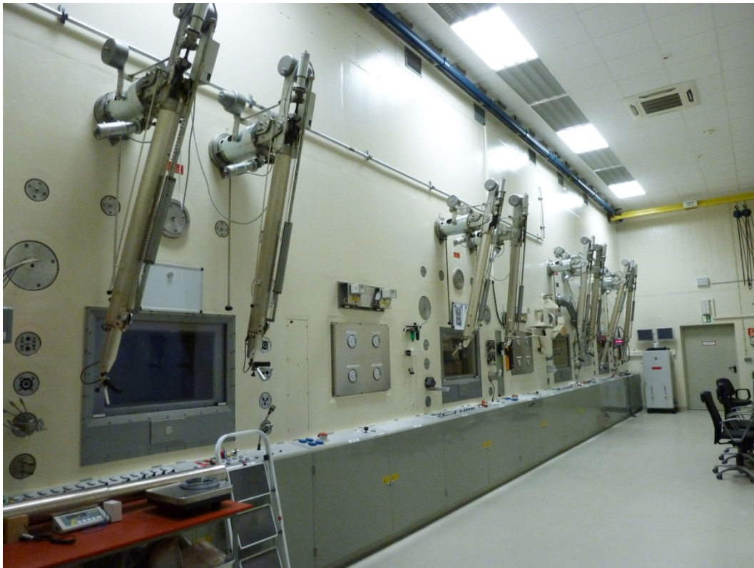
Abbildung 4-13: Bediengang mit Blick auf die Manipulatoren und Bleiglasfenster
