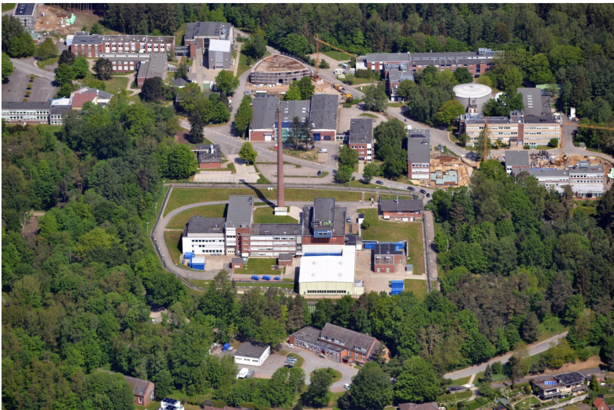
Abbildung 4-1: Luftbild der FRG und des HL sowie der TBH (Stand: 2016)
